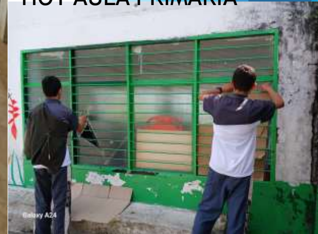
ADECUACION SALA MAESTROS- HOY AULA PRIMARIA
