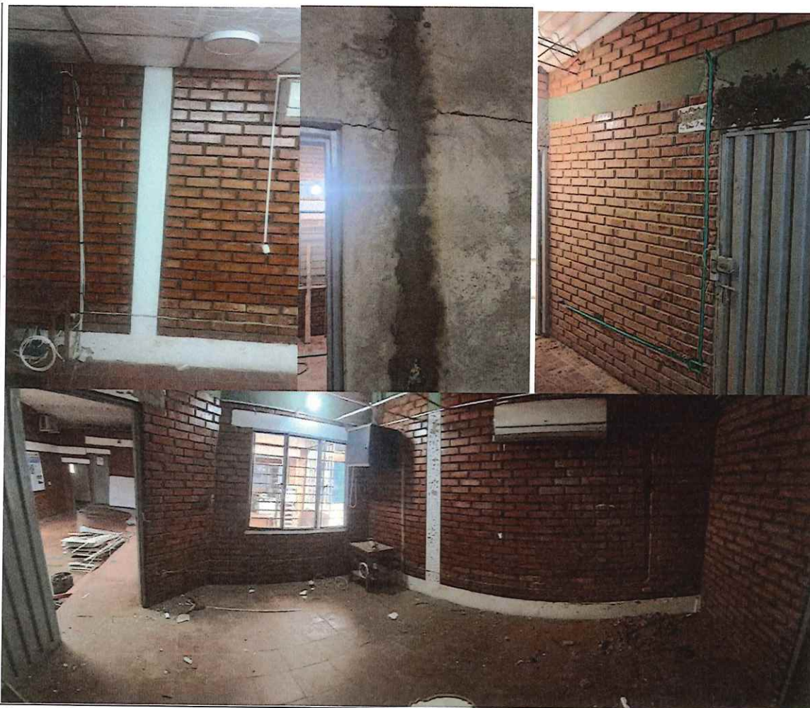
17 Suministro e instalación de enchape de piso ceramica 50*50
